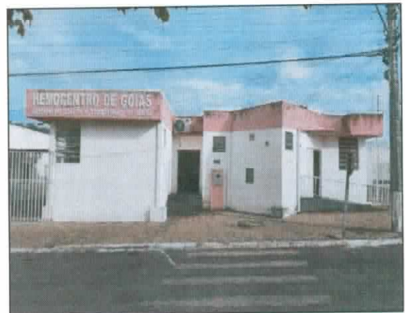
Imagem da estrutura da unidade de Iporá antes de início da reforma.
